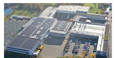
PV-Anlage auf dem Dach der Kopp Zentrale in Kahl am Main
